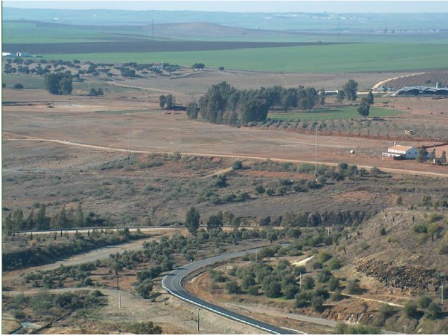
Fotografía de la situación final de la escombrera S9
